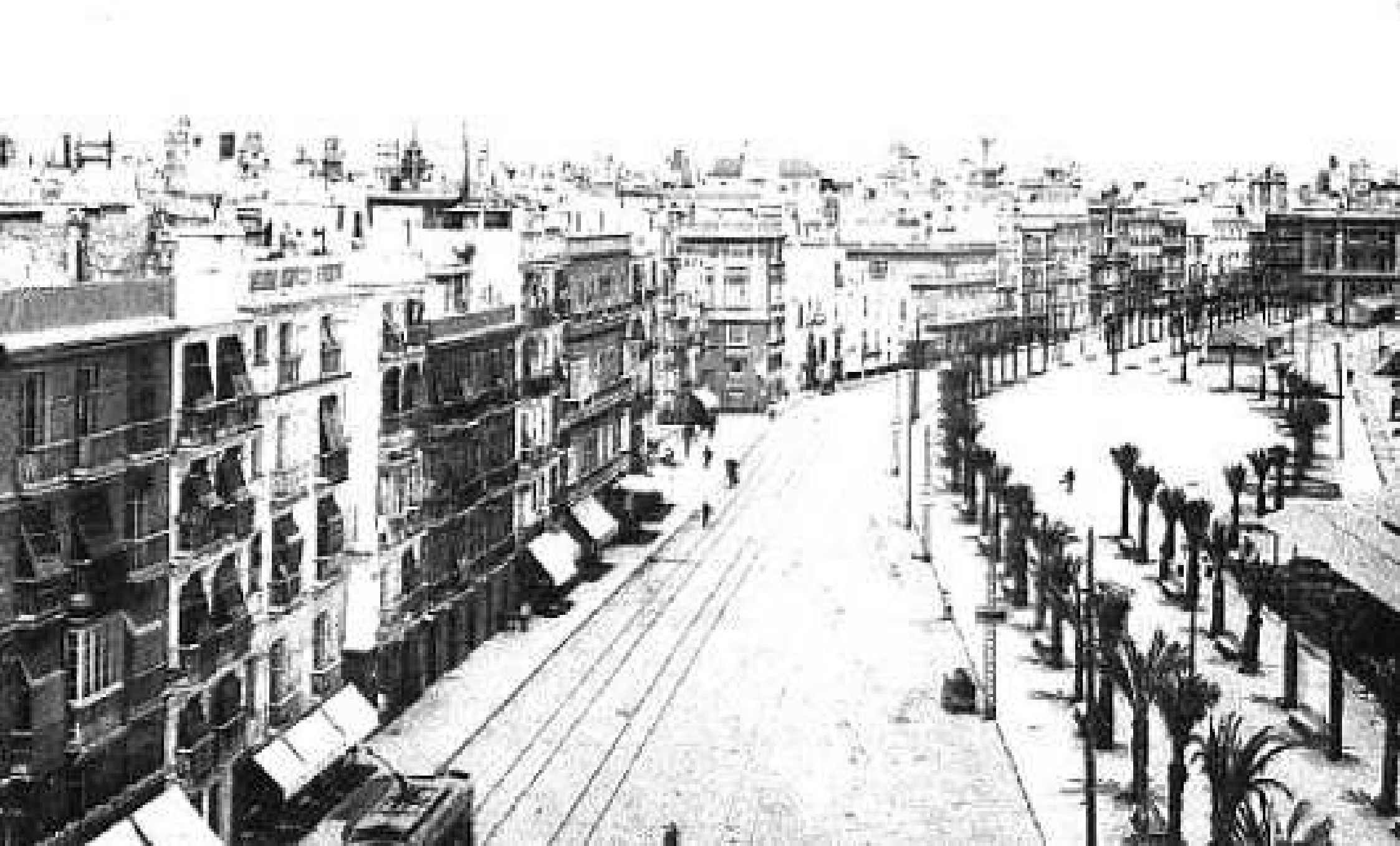
CALLE DE ISAAC PERAL Y BULEVARD CANALLIAS
